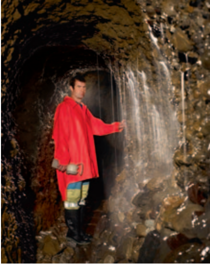
Blick in den Fassungsstollen der Kohlbodenquelle. Aus dem Schotter quillt reinstes Quellwasser.
