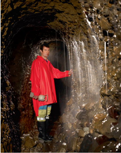
Blick in den Fassungsstollen der Kohlbodenquelle. Aus dem Schotter quillt reinstes Quellwasser.
